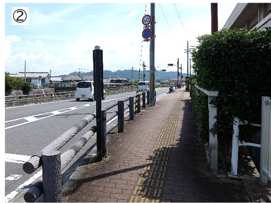
●誘導用ブロックが JIS 規格に適合していない。
