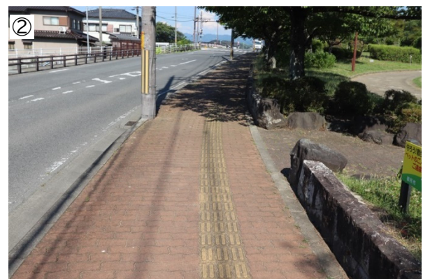
② ●誘導用ブロックが JIS 規格に適合していない。
