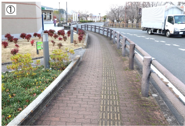
●誘導用ブロックが JIS 規格に適合していない。
