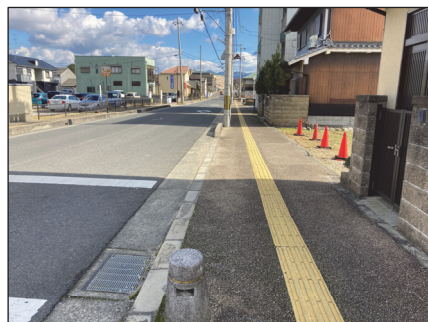
図：歩道整備状況図(左)とカラー舗装、歩行空間バリアフリー化の例(右)
