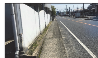
国道24号 駅周辺の歩道
