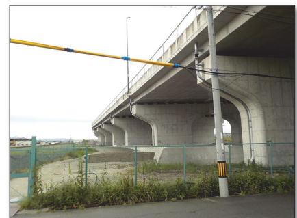
一般部（側道）の未整備区間
