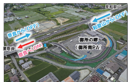
御所南インターチェンジ
