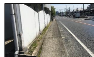
国道24号 駅周辺の歩道
