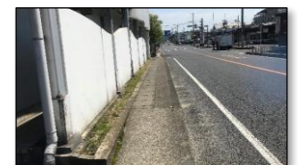
国道24号 駅周辺の歩道
