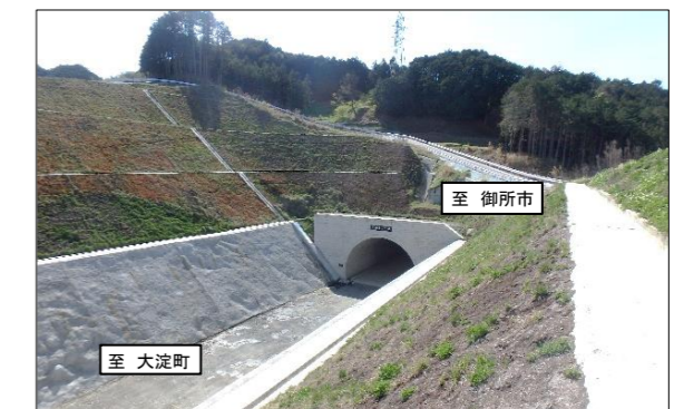
図:高取バイパス(高取トンネル/高取町清水谷)の整備状況
