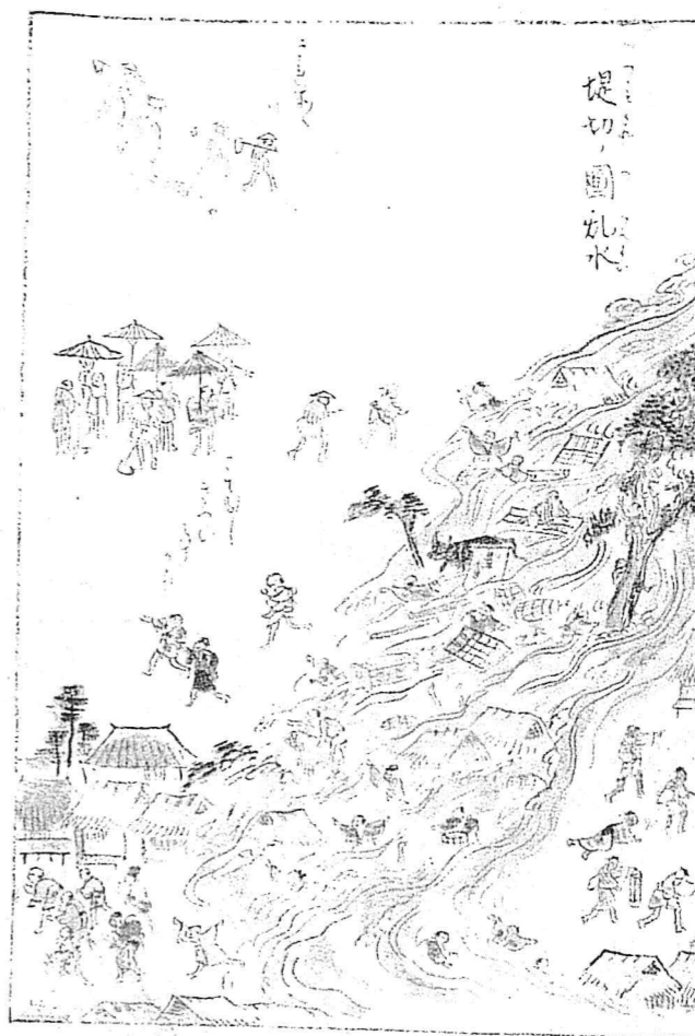
大和御所町誌より
