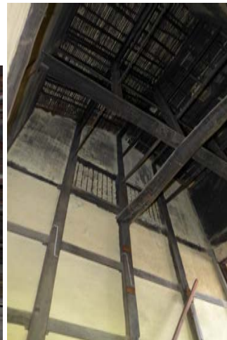
澤村家横向店(17世紀中期)土間
