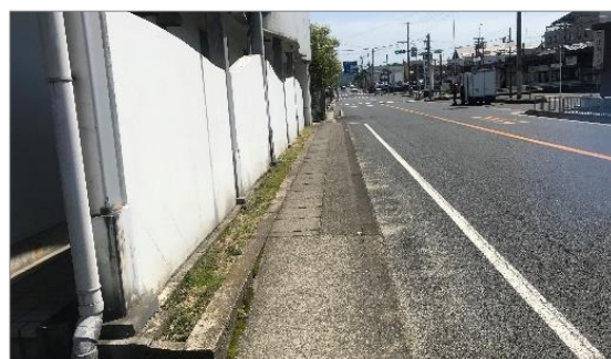
国道24号 駅周辺の歩道
