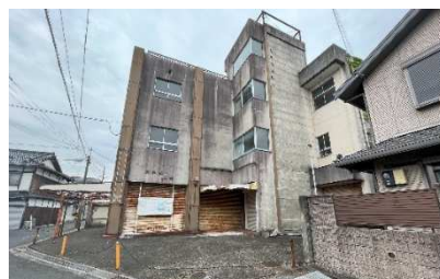
▲解体前の旧和光ビル
