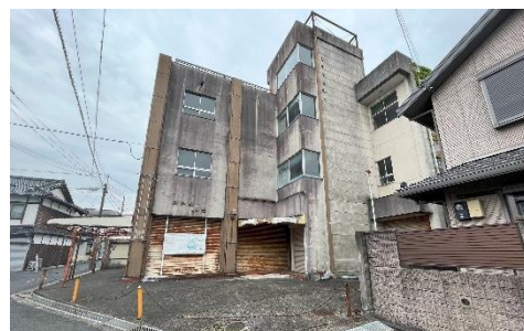
▲旧和光ビルの現状
