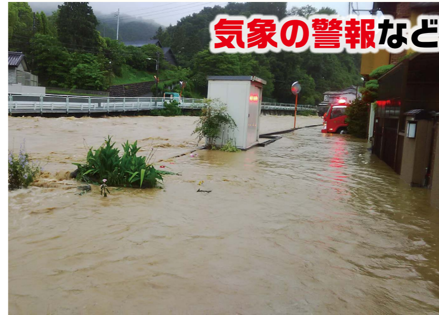
豪雨により曾我川が氾濫した古瀬地区 (令和5年6月)
