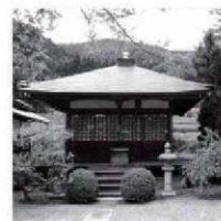
菩提寺 伏見 奈良時代に行基が開いた寺の ひとつ。道場「菩提院」の後継 と伝えられている。 御所市伏見
