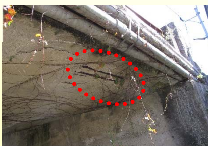
主桁の損傷（鉄筋露出）
