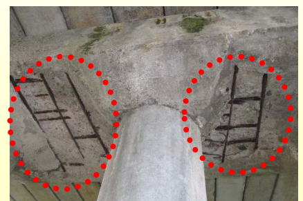
橋脚の損傷（鉄筋露出）
