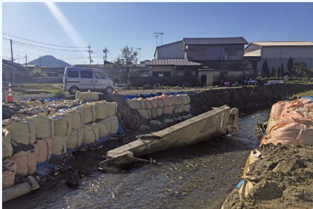
▼川が氾濫し、橋が流された秋山川
