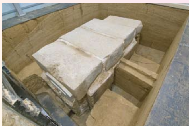
写真3 高松塚古墳 横口式石槨の外観 (石材の隙間は漆喰で充填している) (写真提供: 独立行政法人 奈良文化財研究所)
